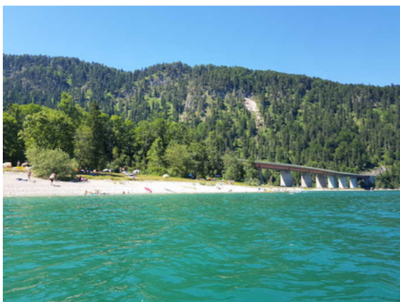
Einsetzstelle südlich der Faller-Klamm-Brücke
